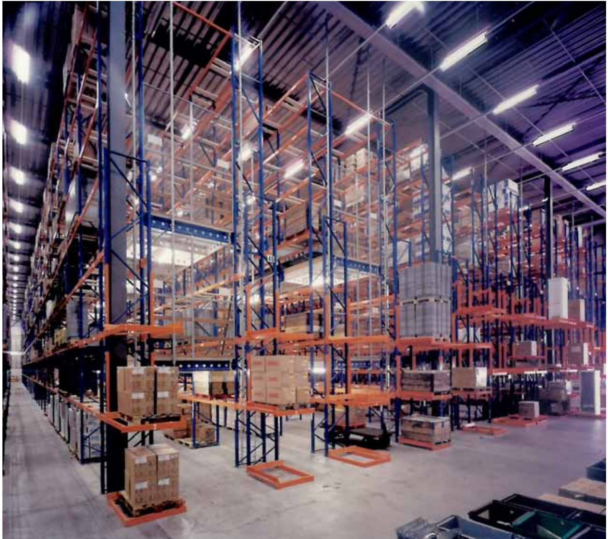
Palletstellingen met daartussen gangen met orderverzamel-vloeren in meer verdiepingen, bediend door een smalle-gangen-truck.
